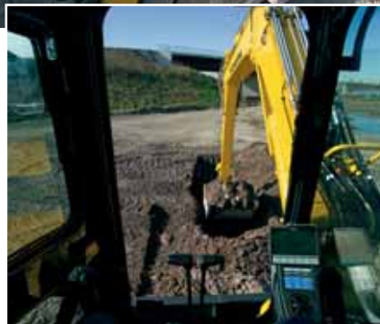
Großzügige Verglasung für hervorragende Rundumsicht
