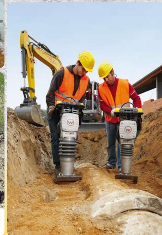
La pilonneuse vibrante à 2 temps
