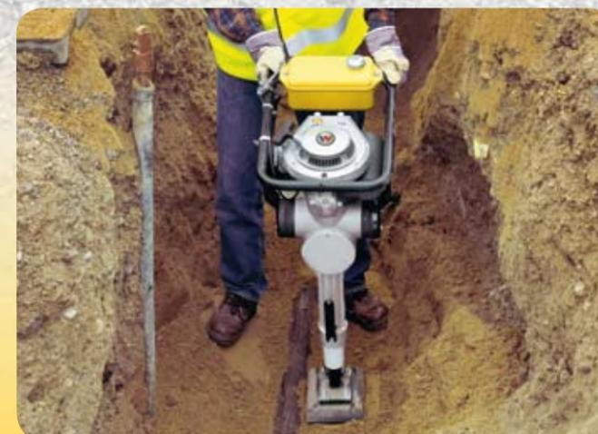
La pilonneuse vibrante à 2 temps BS 30 présente de clairs avantages vis-à-vis des moteurs à 4 temps qui ne doivent pas fonctionner inclinés à plus de 20° :
