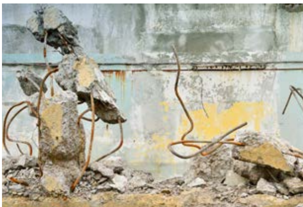
Rozbiórka konstrukcji betonowych
