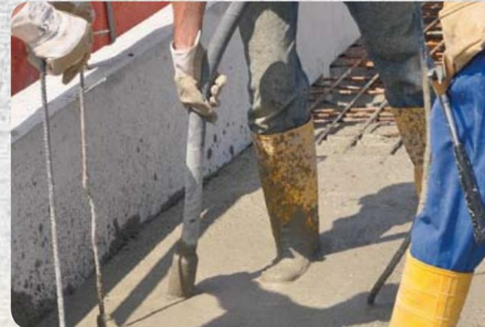
Vibradores internos de tecnología puntera para el tratamiento de hormigón: IRSEN e IRSE-FU.
