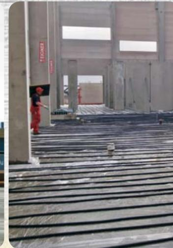
**Paso 9:** El tratamiento posterior evita un enfriamiento y una desecación demasiado rápidos durante el endurecimiento. El calefactor de superficies E 700M de Wacker Neuson es idealmente apropiado para este proceso ya que garantiza un proceso de fraguado estable debido a su potencia calorífica de área extendida.
