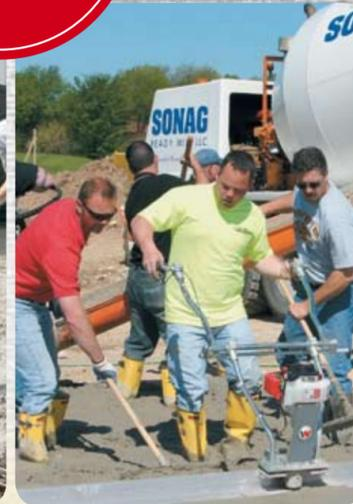
**Paso 7:** Con la regla vibratoria queda garantizado que la superficie de hormigón sea plana y se cumpla con la altura exigida. De este modo, el hormigón estará preparado óptimamente para la aplicación de las fratasadoras.
