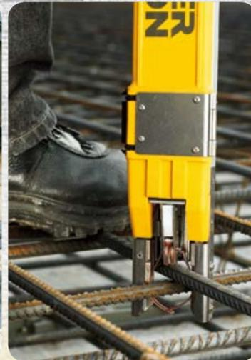
**Paso 4:** Se instala la armadura y se trata con las atadoras de armaduras y las máquinas cortadoras de varillas de Wacker Neuson.
