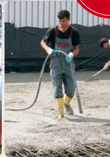
**Paso 6:** El hormigón fresco deberá ser compactado a continuación. De este modo, obtiene su calidad de primera. Para esto, se ofrece la amplia gama de vibradores internos de Wacker Neuson.
