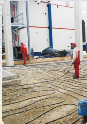
**Paso 1:** Según la situación de temperatura, el suelo deberá descongelarse y calentarse antes del tratamiento. En esto, el E 700M de Wacker Neuson es el acelerador ideal del proceso.
