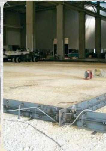
**Paso 3:** Se instalan los elementos limitadores de la superficie.
