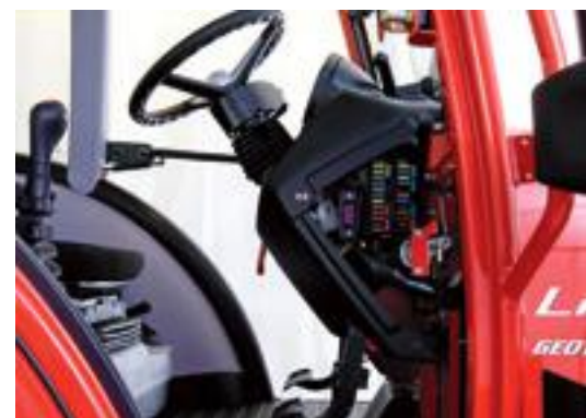
Gut zugänglicher Sicherungskasten
